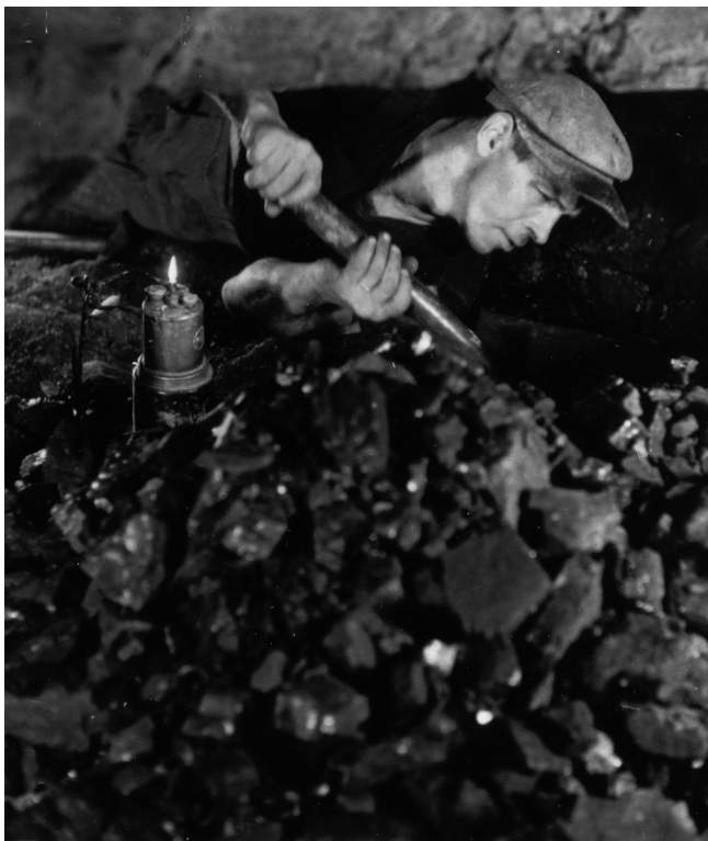
Kohleabbau in Käpfnach um 1943. Ein Bergmann «Häuer» arbeitet liegend im engen Abbauschlitz. Einzige Lichtquelle war die Karbidlampe vorne Ortsbildarchiv Horgen.
