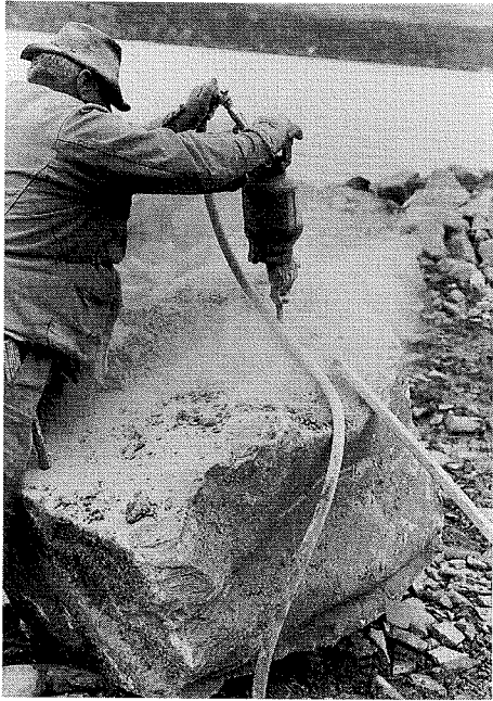
Um Platten von Blöcken zu trennen, wird Loch an Loch gebohrt.
