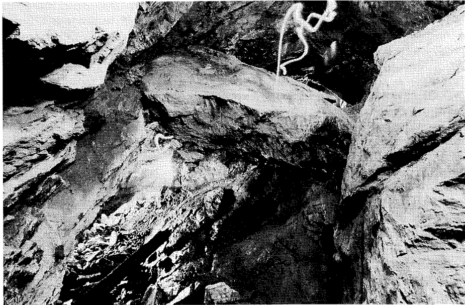
Figure 3: Zone excavée dans le niveau II de la mine de Grand-Praz. Le gros bloc au centre de l'image provient du plafond et s'est coincé entre les deux parois de la galerie.
