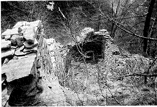
Abb. 43: Überreste der Seilbahnstation Camussetta. Foto Hans-Peter Bärtschi, Winterthur, 1988.
