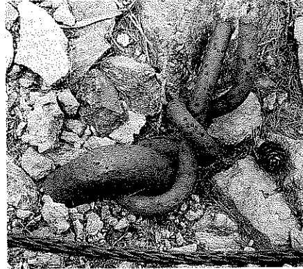
Abb. 45 (Mitte rechts): Drahtseil von 1,5 Zentimeter Durchmesser und schmiedeiserne Verankerung für die Nebenseilbahn, Station Bruno. Foto Hans-Peter Bärtschi, Winterthur, 1995.
