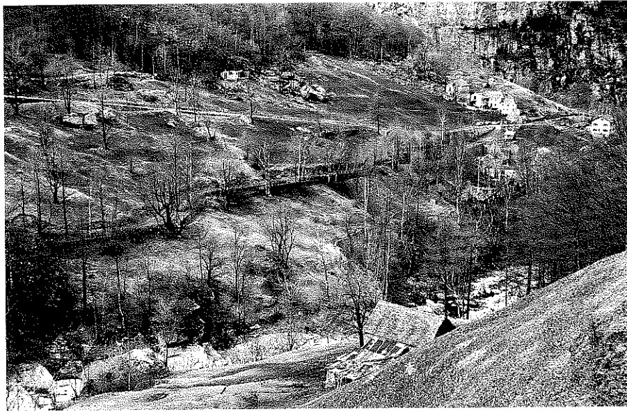
Abb. 20: Deutlich hebt sich die Stützmauer des Oberwasserkanals als künstlicher Eingriff in die Hanglehne oberhalb des Minenbodens ab. Foto Hans-Peter Bärtschi, Winterthur, 1995.
