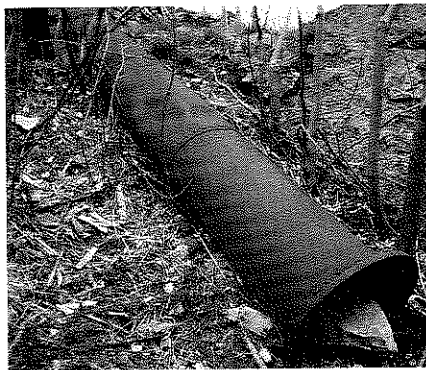
Abb. 21: Von den beiden Druckrohren, die das Wasser den Arrastramühlen zuleiteten, ist eines teilweise erhalten. Foto Hans-Peter Bärtschi, Winterthur, 1995.
