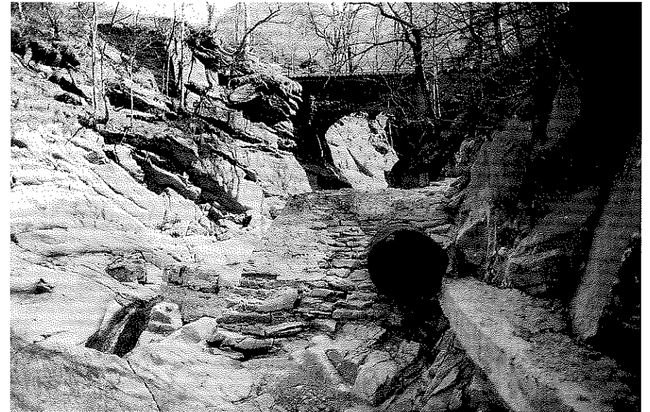
Abb. 9: Neue und alte Brücke zum Hof Biel im Grossen Wasser. Foto Hans-Peter Bärtschi, Winterthur, 1995.
