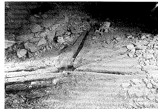
Spurnagelweiche in einem alten Stollen auf Mot Madlain. Foto: Hans-Peter Stolz.
