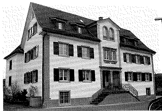
Abb. 31: In diesem geschichtsträchtigen Oberli-Haus im Oberdorf Mels wohnten Landammann Jacob Paul Natsch-Lendi, später die Glashütten-Direktoren Landammann Joseph Anton Oberli-Natsch (1761–1833) und dessen Sohn Rudolph Maria Oberli-Oelhafen (1797–1850). Die Geschichte des Oberli-Hauses wird von NATSCH (1991) beschrieben. Der heutige Eingang mit den Treppenstufen aus den Castels-Steinbrüchen wurde erst um 1840 erstellt.
