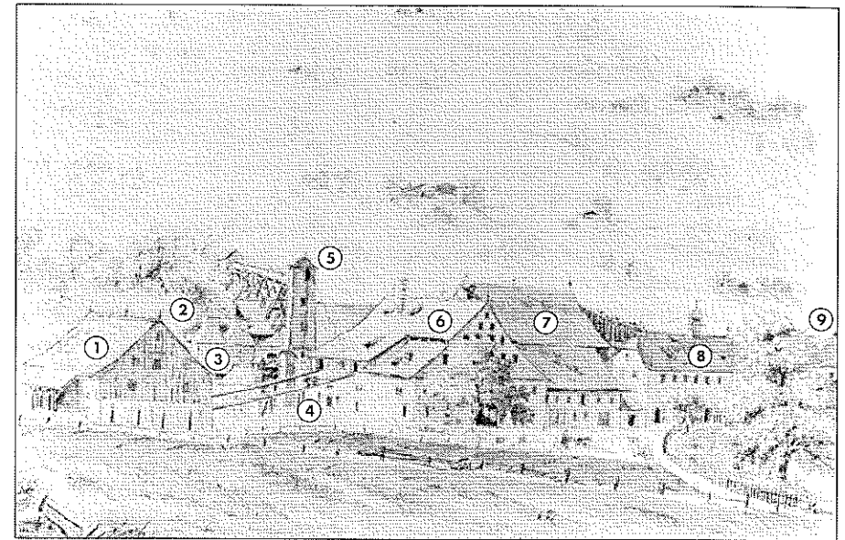
Abb. 24: Die Verhüttungsanlagen in Plons um 1865: 1. Lagerschopf für die aufbereiteten Erze, 2. überdachte Erztröge (Dächer knapp erkennbar), 3. zwei Röstöfen, 4. Rollbahn für den Antransport der aufbereiteten Erze auf den Möllerboden, 5. Turm des Wassertrommelgebläses, 6./7. Hochofengebäude mit Pochwerk und Kohlenmagazinen im Parterre, der Platzmeisterwohnung und der Werkschmiede im ersten Stock, mit den Wohnungen des Schmelzmeisters, des Schmieds und seines Ofenknechtes und mit dem Möllerboden auf der zweiten Etage und Aufbewahrungsräumen im dritten Stock, 8. Ökonomiegebäude, 9. Herrenhaus (heute noch bestehend). Bleistiftzeichnung von D. Neher-Fischer, ca. 1860. (Privatbesitz).
