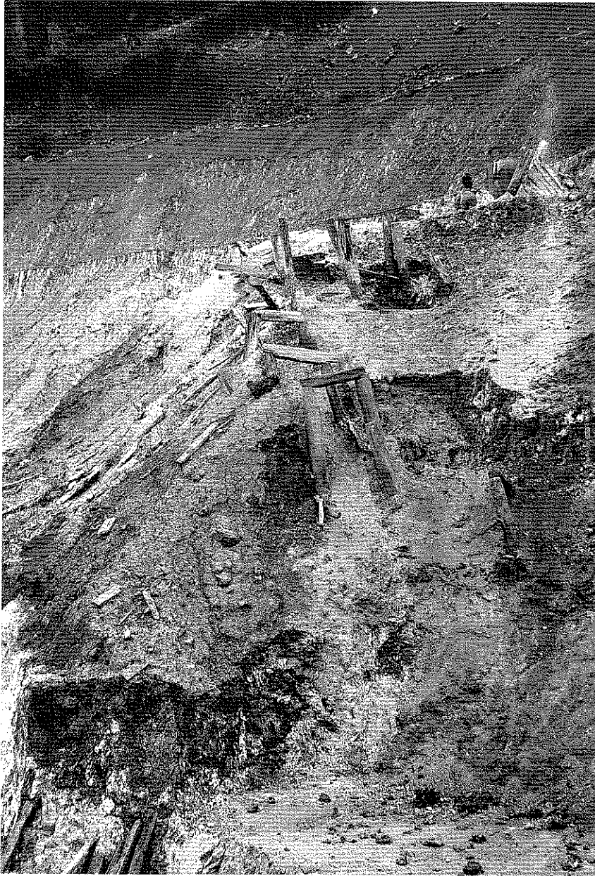
Abb. 1: Lausen-Huppergrube. Beim Abbau von Huppererde kamen in den Dreissiger Jahren Verspriessungen alter Stollen zum Vorschein, die zu unbekannter Zeit die grossen Bohnerzvorkommen in diesem Gebiet erschlossen hatten.
