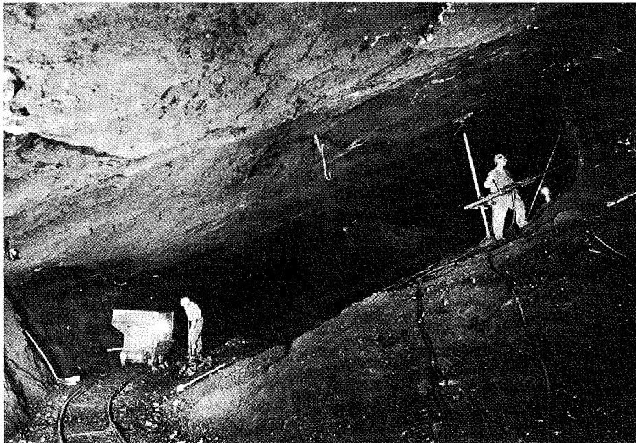
Bild 9: Abbau mit Mineur und Handlanger, 1943. Auf Galeriegeleise Rollwagen mit Seitenklappe.
