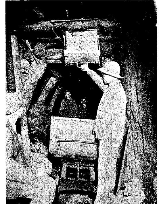
Abb. 22: Stollenausbau. Schieberverschluss des Füllrohrs. Ein Arbeiter in Arbeitskleidung (Foto aus Beitr. Geologie der Schweiz, geotechn. Serie, Lief. 12, 1925)
