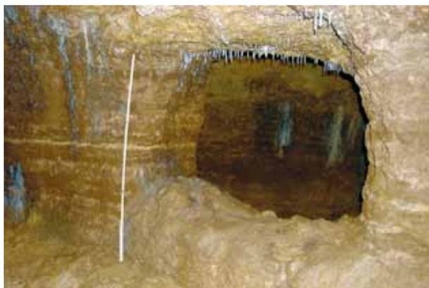
Fig. 26 : Recoupe entre deux galeries dans la mine de Oye-et-Pallet (Doubs). Cliché M. Cottet et M. Bôle.
