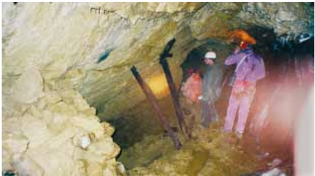
La galerie principale d'orientation  $N = 152^\circ$  s'incline légèrement vers l'Ouest  $N = 197^\circ$  à 9,30 m de l'entrée. À cet endroit, la galerie mesure 1,36 m de hauteur sur 1 m de largeur. Deux niches à lampes (10 x 10 cm) creusées à 0,90 m du sol de la galerie marquent ce changement de direction. Sur la paroi Ouest sont entassés plusieurs déblais de stériles soigneusement empilés.
