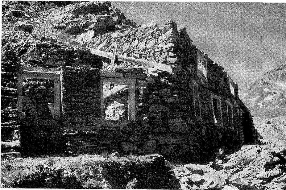
*1991 wurde das Dach des Knappengebäudes von einem Föhnsturm weggerissen (Foto A.B.).*
